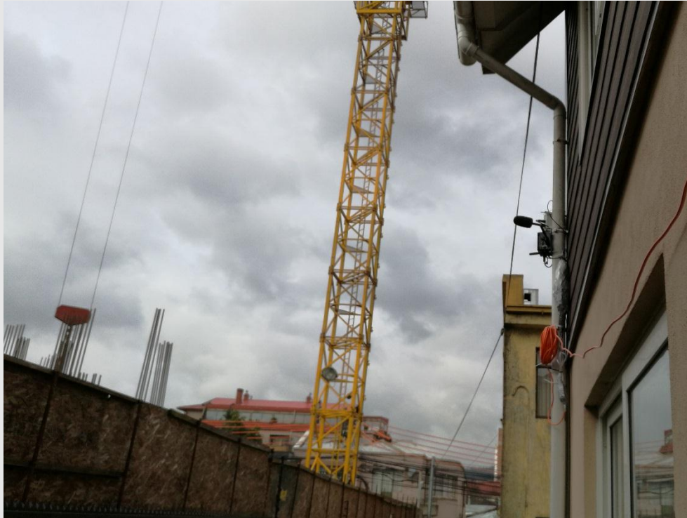
Día de Instalación monitoreo: 22-06-2017 Sin completar barreras acústicas
