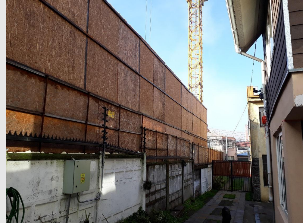
Fiscalización Ambiental: 28-06-2017 Barreras acústicas finalizadas
